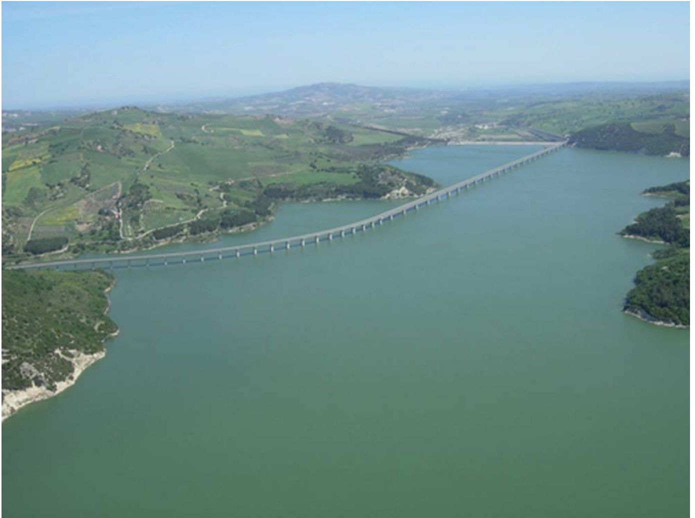
Diga Ponte Liscione
