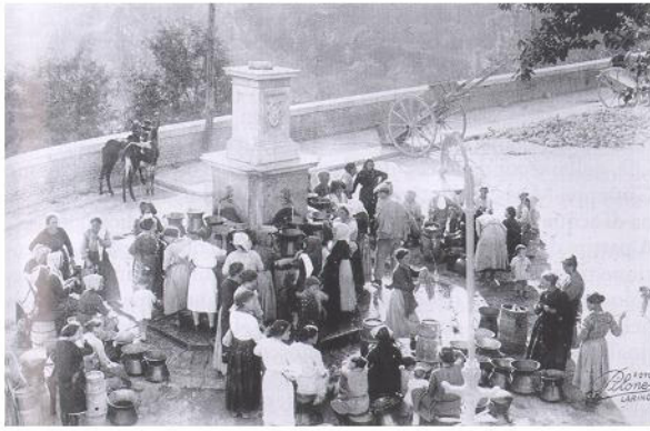
Fig. 10. Fontana Nuova, 1922 (Larino CB). La fontana, come luogo di aggregazione dove le donne si recavano per prelevare l'acqua con le tine , recipienti in rame lucidi e splendenti, o con le botti, sistemate sui carretti, trainati da muli, come si vede nella foto (foto Pilone)
